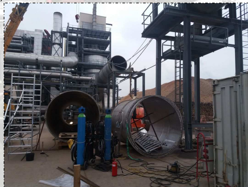
Fot. Montaż kanałów spalin i kompensatorów.
